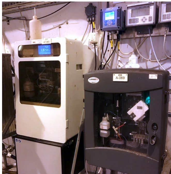
Анализатор Phosphax sigma измеряет как фосфаты, так и общее содержание фосфора. Анализатор Amtax sc показан здесь в модификации с дверцей из оргстекла для установки в помещении.
